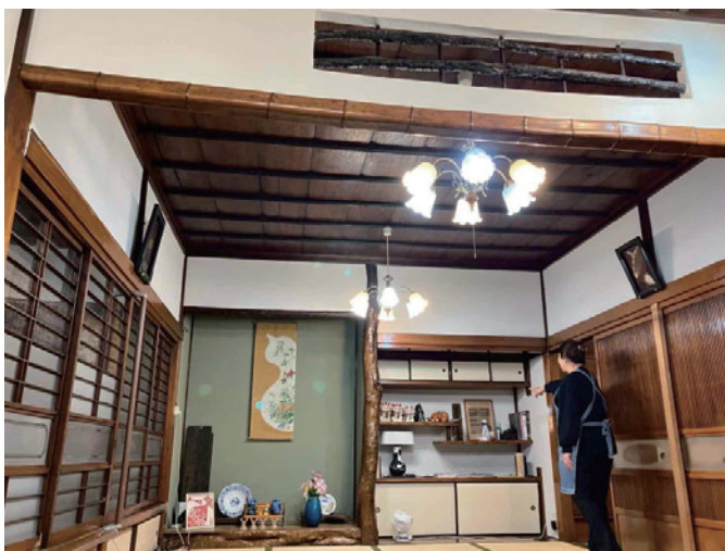
昭和23年に作られた店内は、床柱は百日紅、床の間の鴨居は松、床の間の下は樺、欄間の透かしは梅、長押は竹、天井の竿縁は桜など銘木でいっぱい。在りし日の木場の心意気が詰まっている
